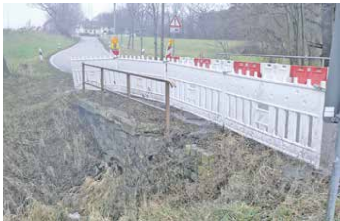
Baumaßnahme K 8769 Durchlass „Rietzschke“
