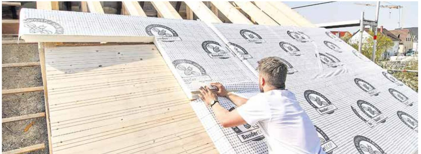
Bei der Aufsparrendämmung erhält das Dach einen lückenlosen Wärmeschutz. So sparen die Bewohner nachhaltig Energie.
