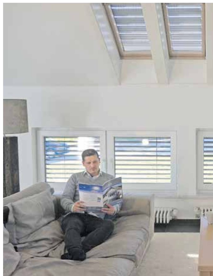
Rollläden mit Lichtschienen lassen gesundes Tageslicht ins Haus, aber sperren die Sommerhitze aus. Fotos: DJDI/Schanz Rollladensysteme
