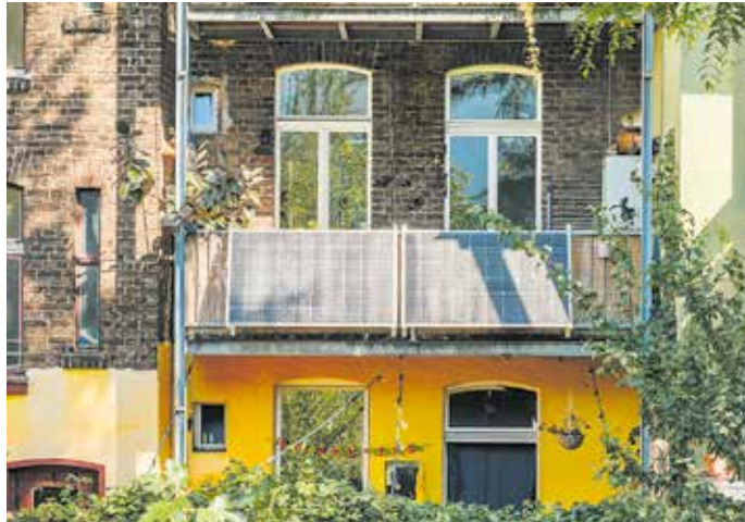
Ein großer Vorteil der Balkonkraftwerke ist ihr unkomplizierter Aufbau und der geringe Platzbedarf. Zieht man um, kann man sie mitnehmen.
